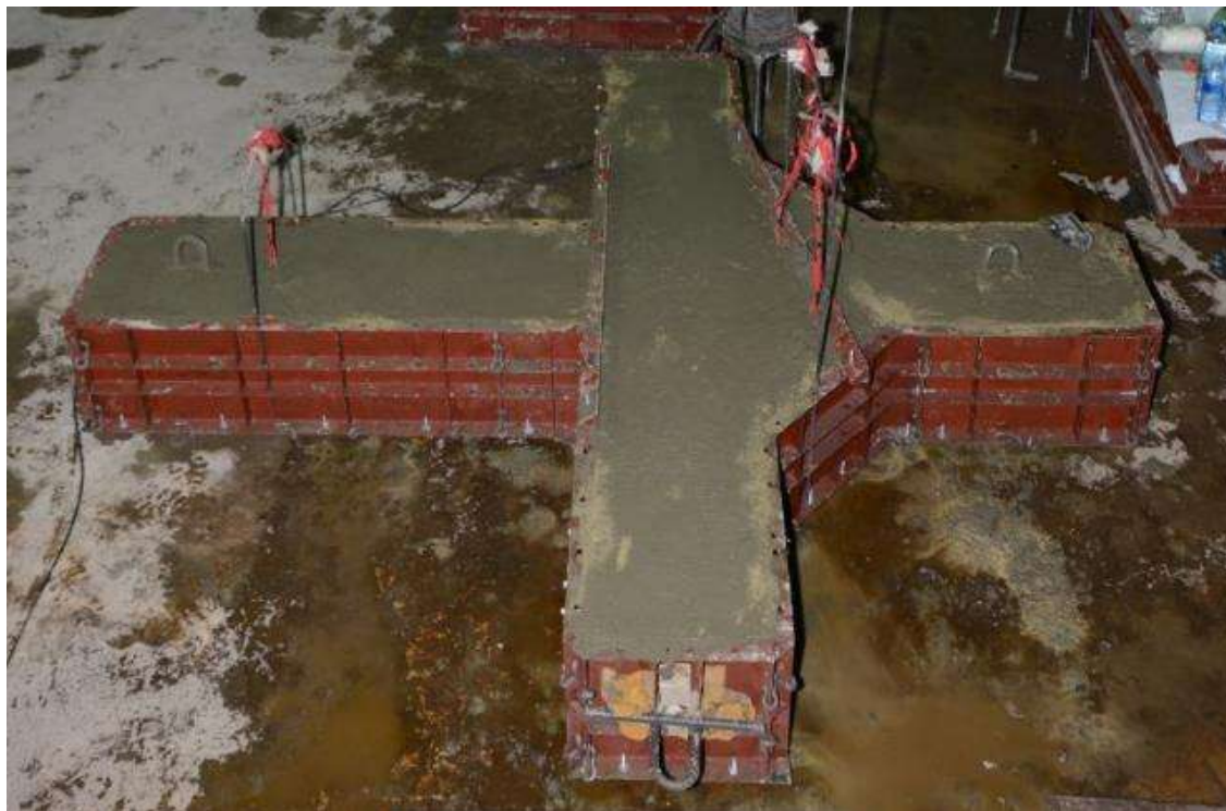
รูปที่ 2-34 ชี้นตัวอย่างคาน-เสา ขณะทำการเทคอนกรีต
