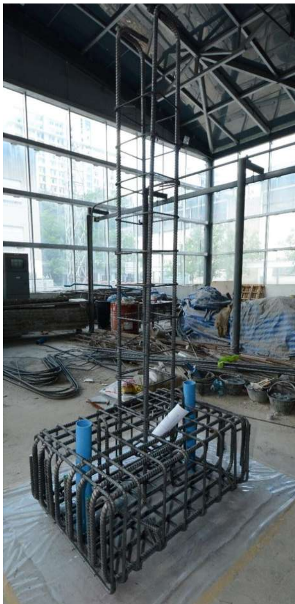
รูปที่ 2-3 ตัวอย่างทดสอบเสาสะพาน
