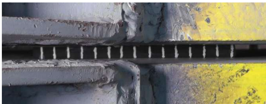
รูปที่ 2-62 แผ่นยางรองสะพานในขณะไม่มีแรงกระทำ
