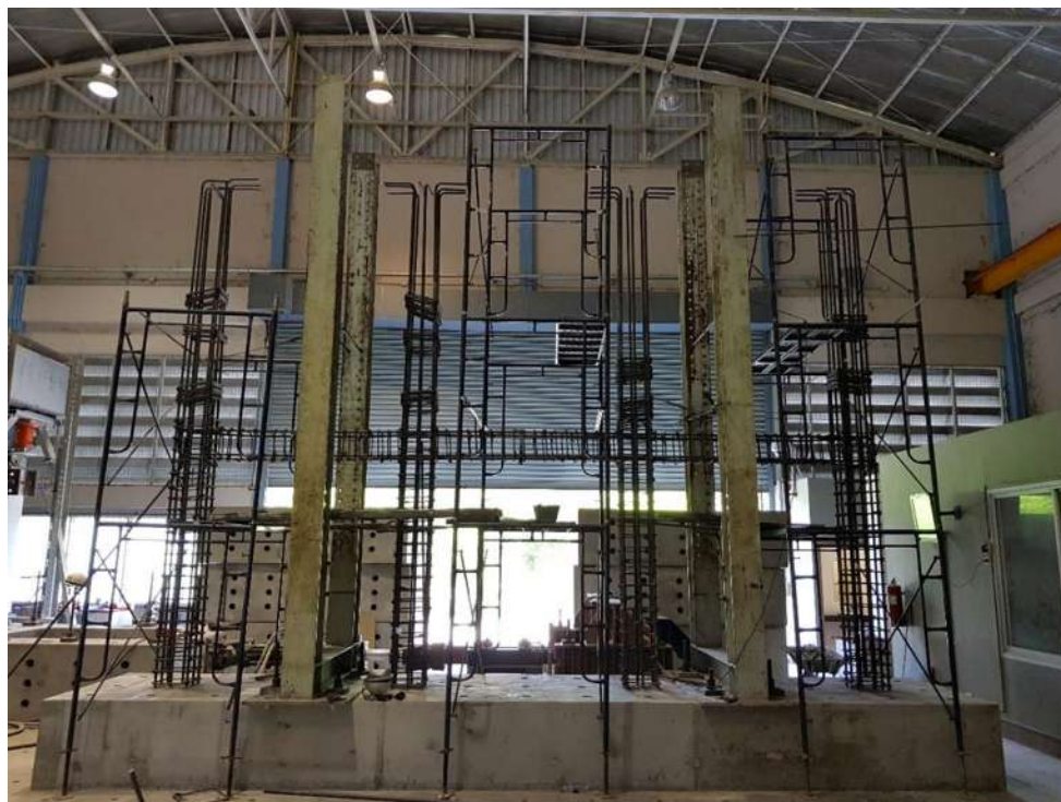
รูปที่ 4-63 ขณะเตรียมการเทคอนกรีตส่วนที่สอง เหนือฐาน
