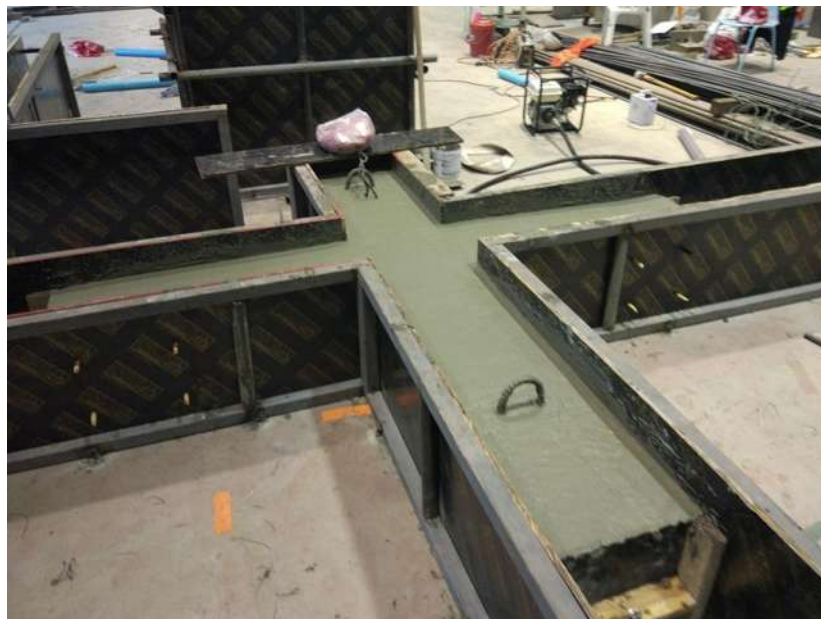
รูปที่ 4-46 ชิ้นตัวอย่างรอยต่อเสาและคานขวาง ขณะทำการเทคอนกรีต
