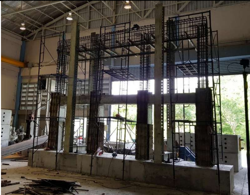
รูปที่ 4-64 ภายหลังการเทคอนกรีตส่วนที่สอง และเตรียมการเทคอนกรีตส่วนบน
