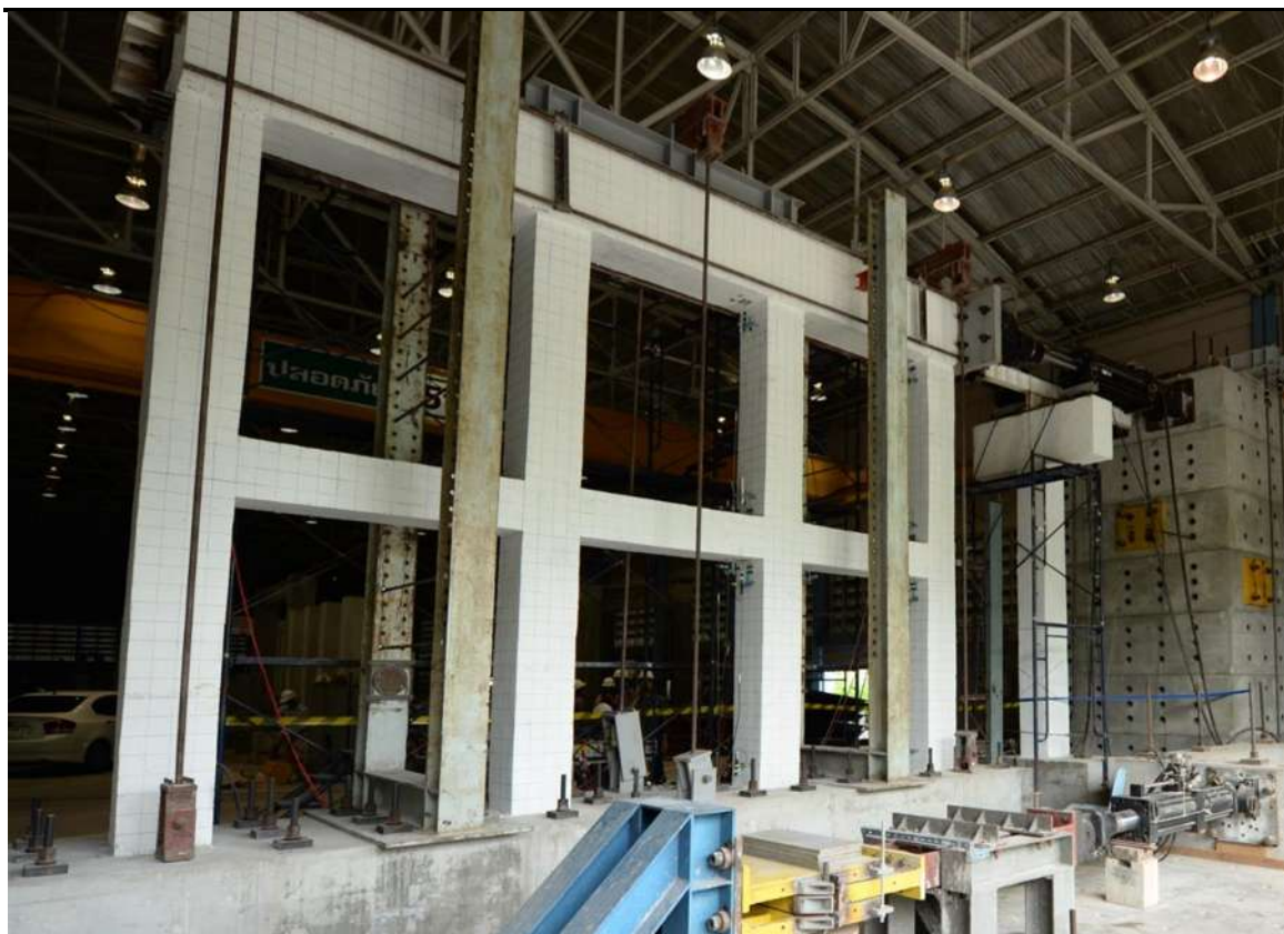
รูปที่ 4-73 การติดตั้งโครงสร้างสะพานเพื่อทำการทดสอบ
