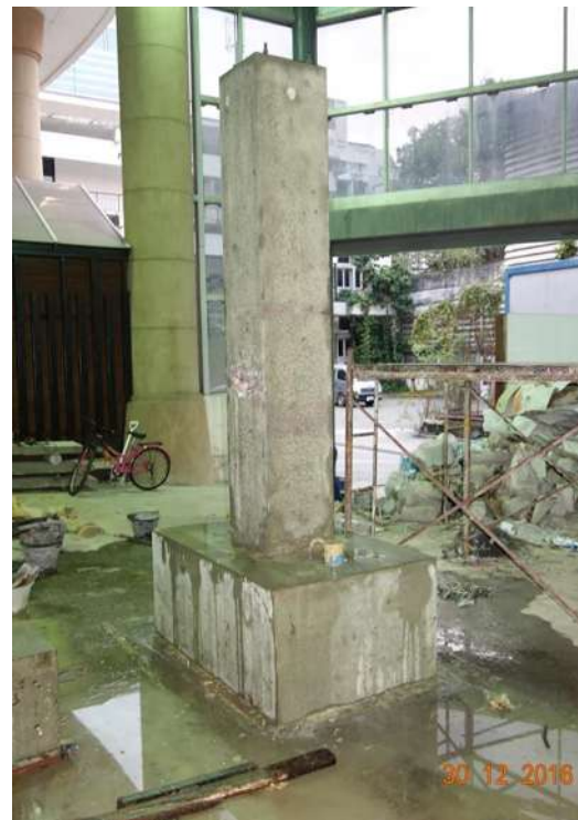
รูปที่ 2-7 ขั้นตอนตัวอย่างเสาขณะกำลังเทคอนกรีต และภายหลังการถอดไม้แบบ
