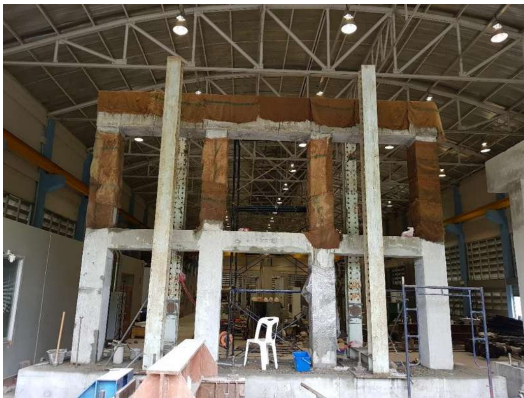
รูปที่ 4-65 ภายหลังการเทคอนกรีตส่วนที่สาม
